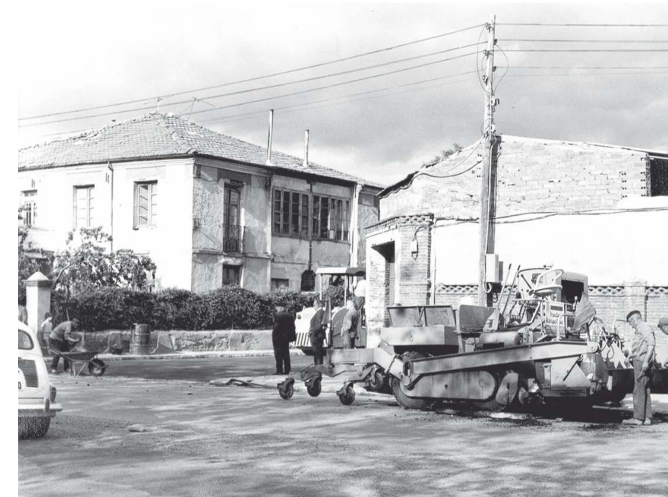
Trabajos de pavimentación en la carretera de Rueda. 197? Fondo Asociación de la Prensa. F 760-1
