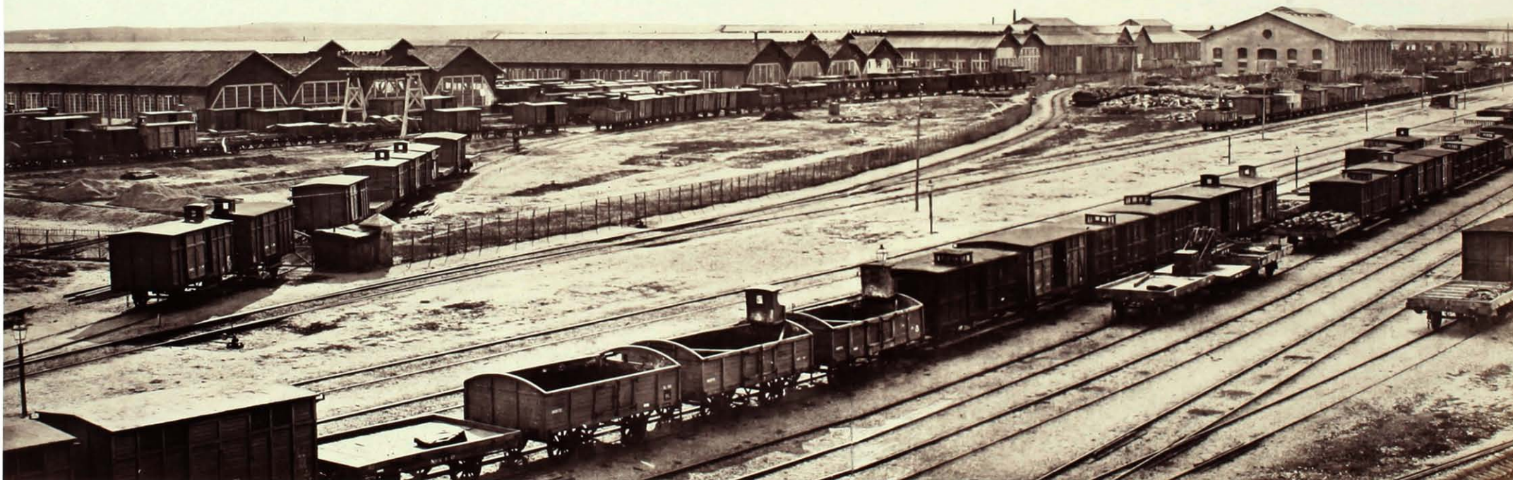
Gare et ateliers à Valladolid
