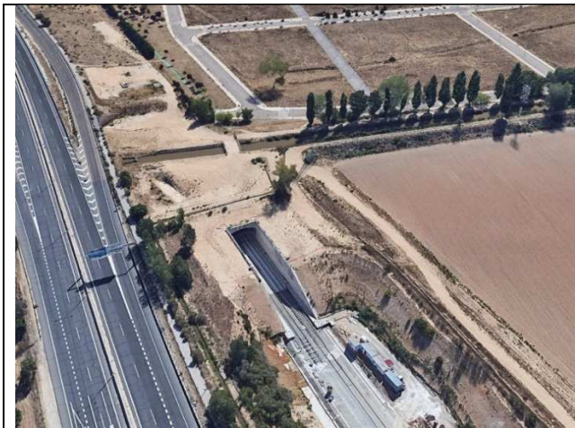
Boca SUR del Túnel del Cerro de San Cristóbal bajo el Canal del Duero
