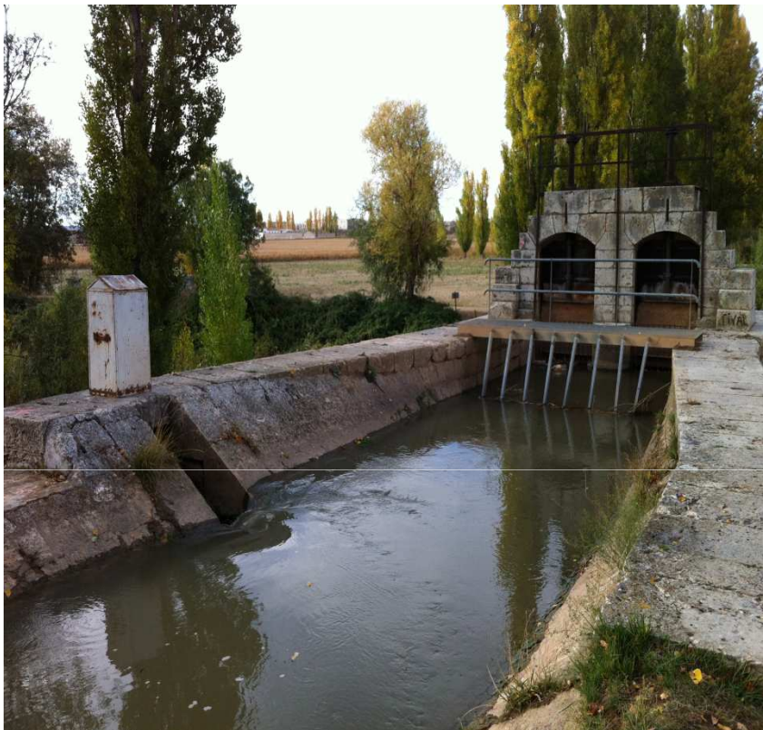
Obra de fábrica (cruce del canal - Esgueva)
