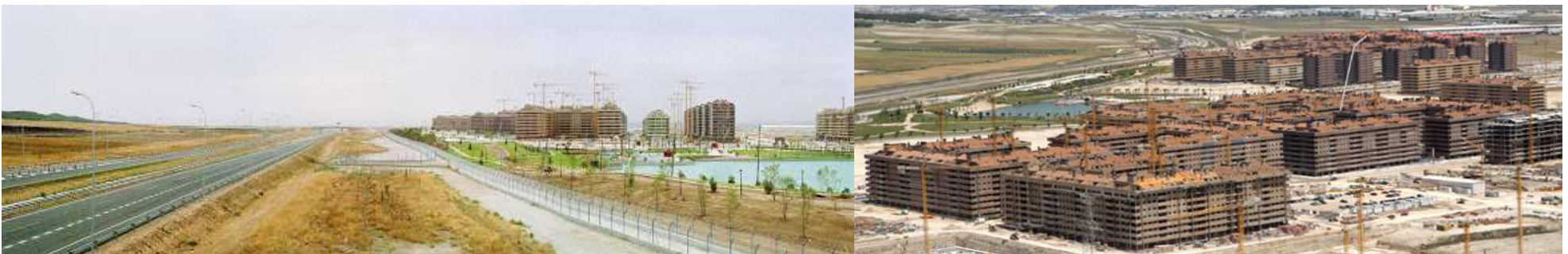
Residencial Francisco Hernando (PAU El Quiñón) y Autopista de peaje Radial 4: Nuevo barrio en Seseña (Toledo)
