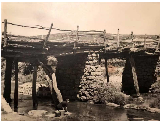
Puente sobre el Pisuerga en Arbejal, Palencia, c. 1930.
