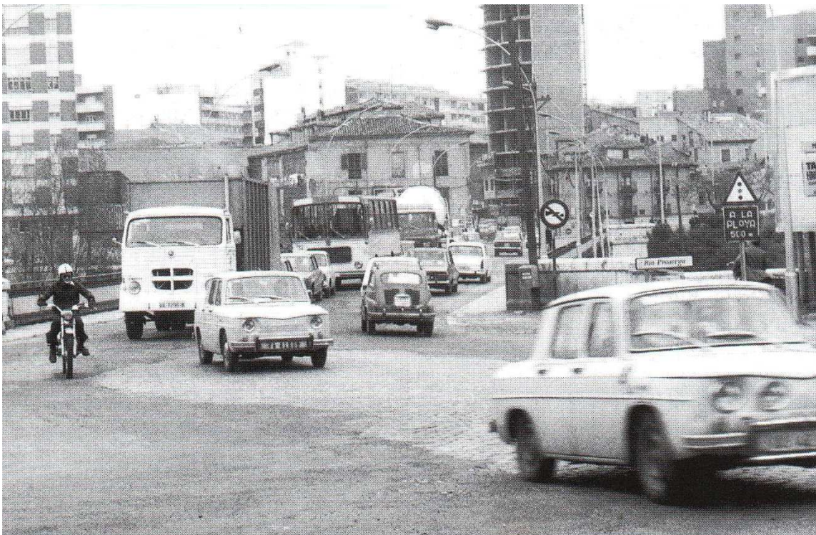
Puente Mayor, años 60. Archivo Municipal de Valladolid.
