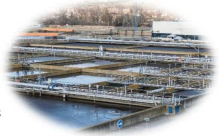
En las instalaciones se reproducen de manera acelerada los procesos naturales de autodepuración que se darían en el medio natural, pero evitando su deterioro. De esta forma se eliminan los sólidos y los desechos orgánicos; reduciéndose la carga de otros contaminantes como el nitrógeno o el fósforo. De esta forma se reduce la eutrofización del río y se contribuye a mantener el oxígeno disuelto en sus aguas; además del caudal ecológico en tiempos de escases hídrica.
