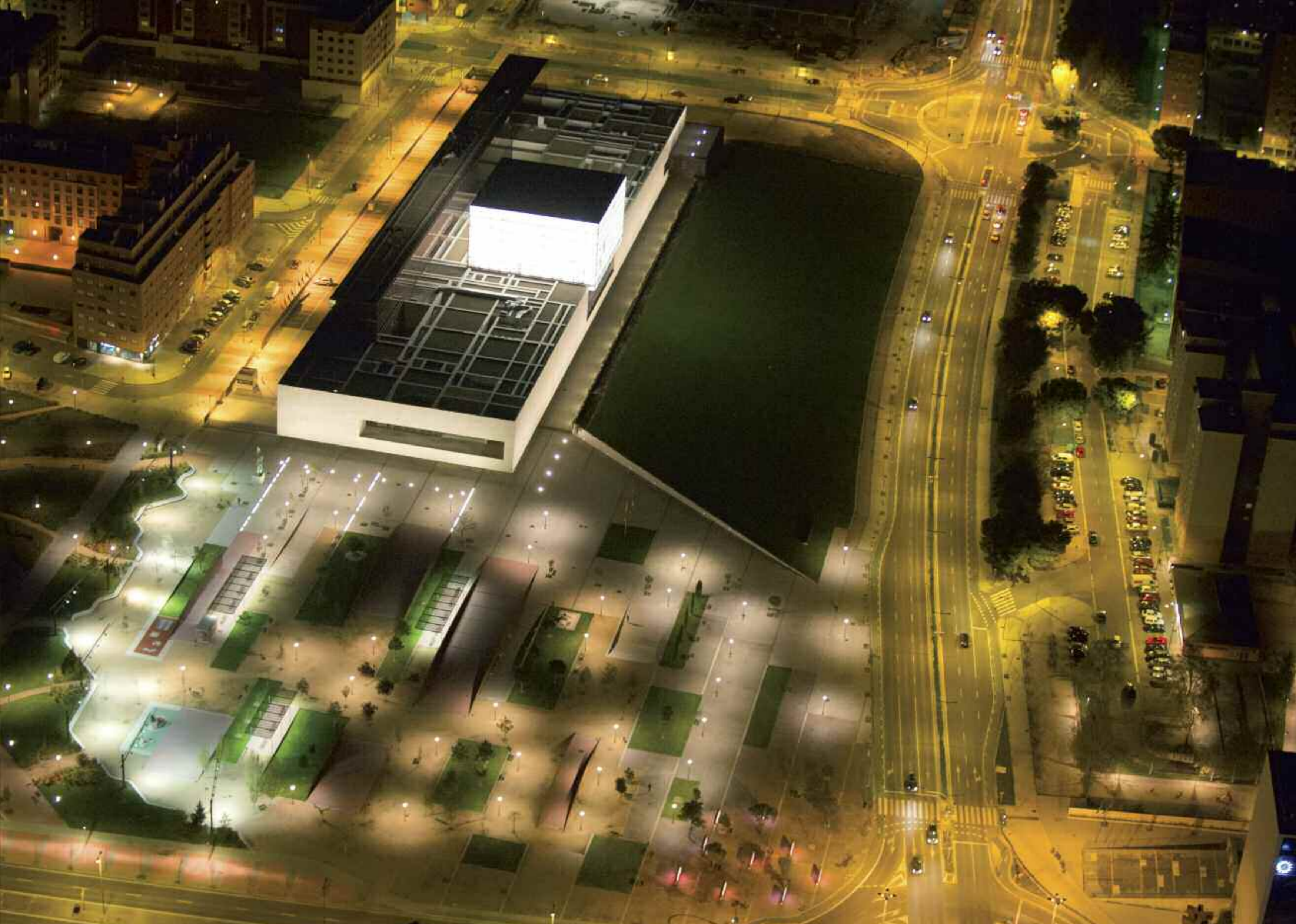
Vista aérea de las Cortes de Castilla y León / Aerial view of the Cortes de Castilla y León Vue aérienne de les Cortes de Castilla y León / Vista aerea delle Cortes de Castilla y León
