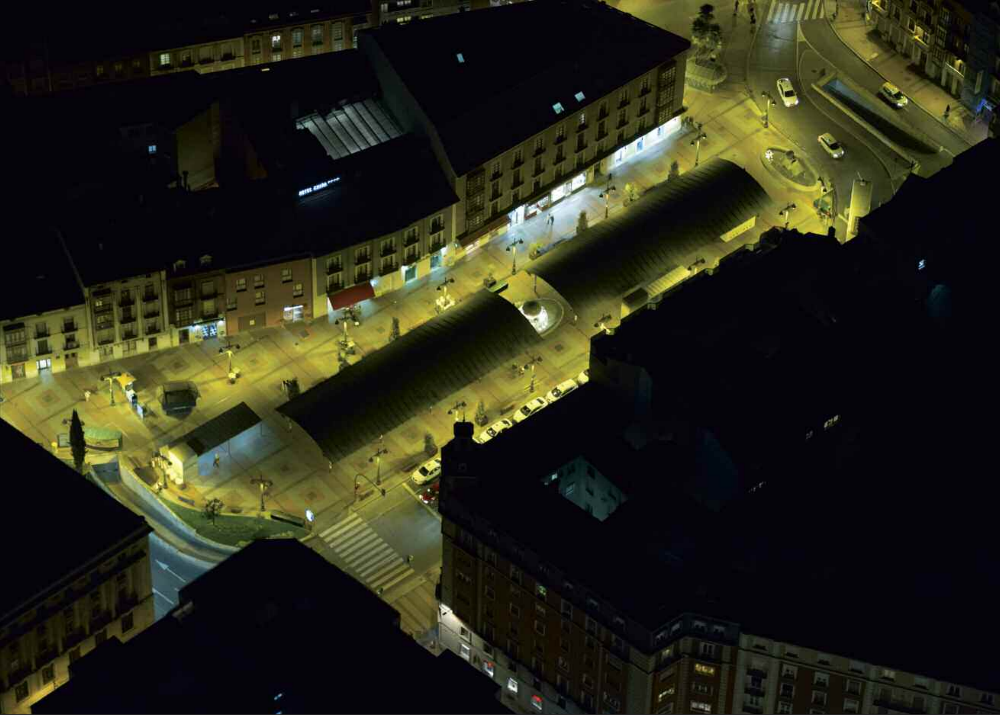
Vista aérea de la Plaza de España / Aerial view of the España Square Vue aérienne de la Place España / Vista aerea della Piazza España
