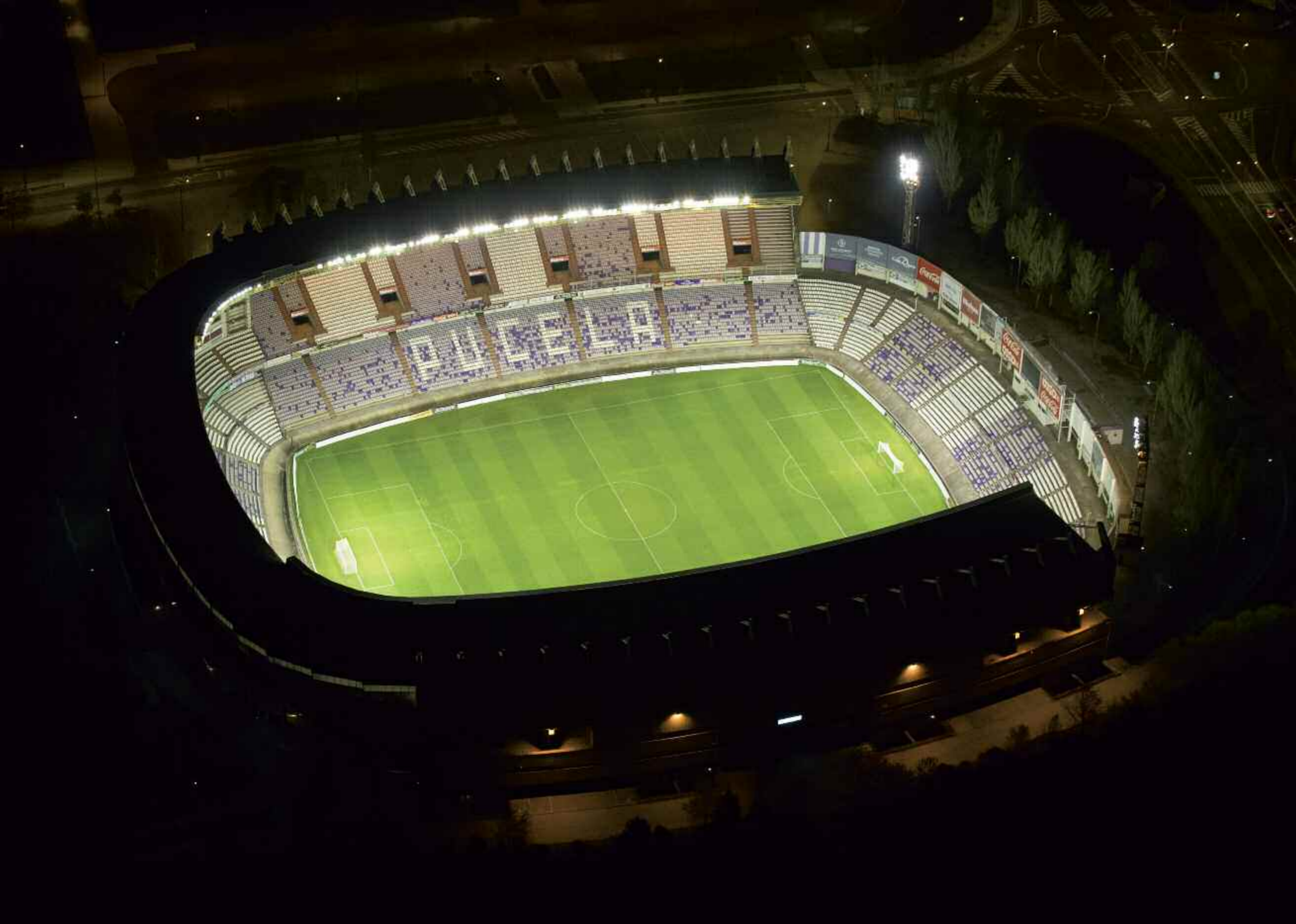
Vista aérea del estadio de fútbol José Zorrilla / Aerial view of the José Zorrilla football stadium Vue aérienne de le stade de football José Zorrilla / Vista aerea dello stadio di calcio José Zorrilla
