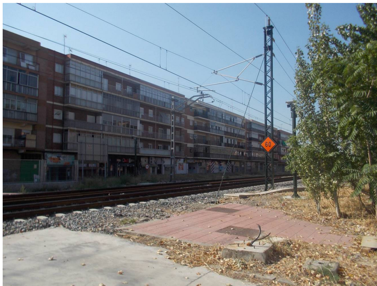
Vista general de la playa de vías
