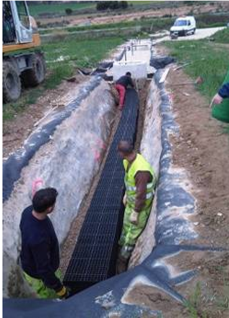
Drenaje sostenible. Zanja drenante conformada por celdas de polipropileno.
