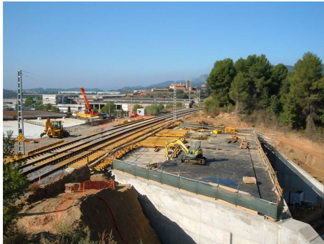
Hinca de cajón esviado similar al proyectado bajo playa de vías de ferrocarril
