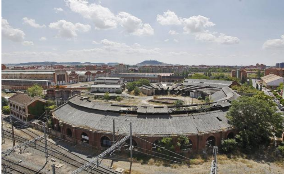
Ilustración 3. Depósito de Locomotoras y otros elementos del espacio Talleres Centrales
