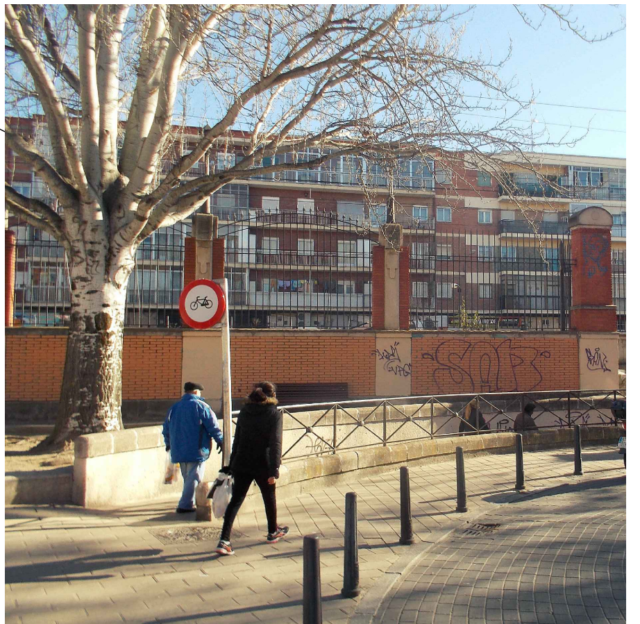
MURO DE CERRAMIENTO A TRASLADAR
