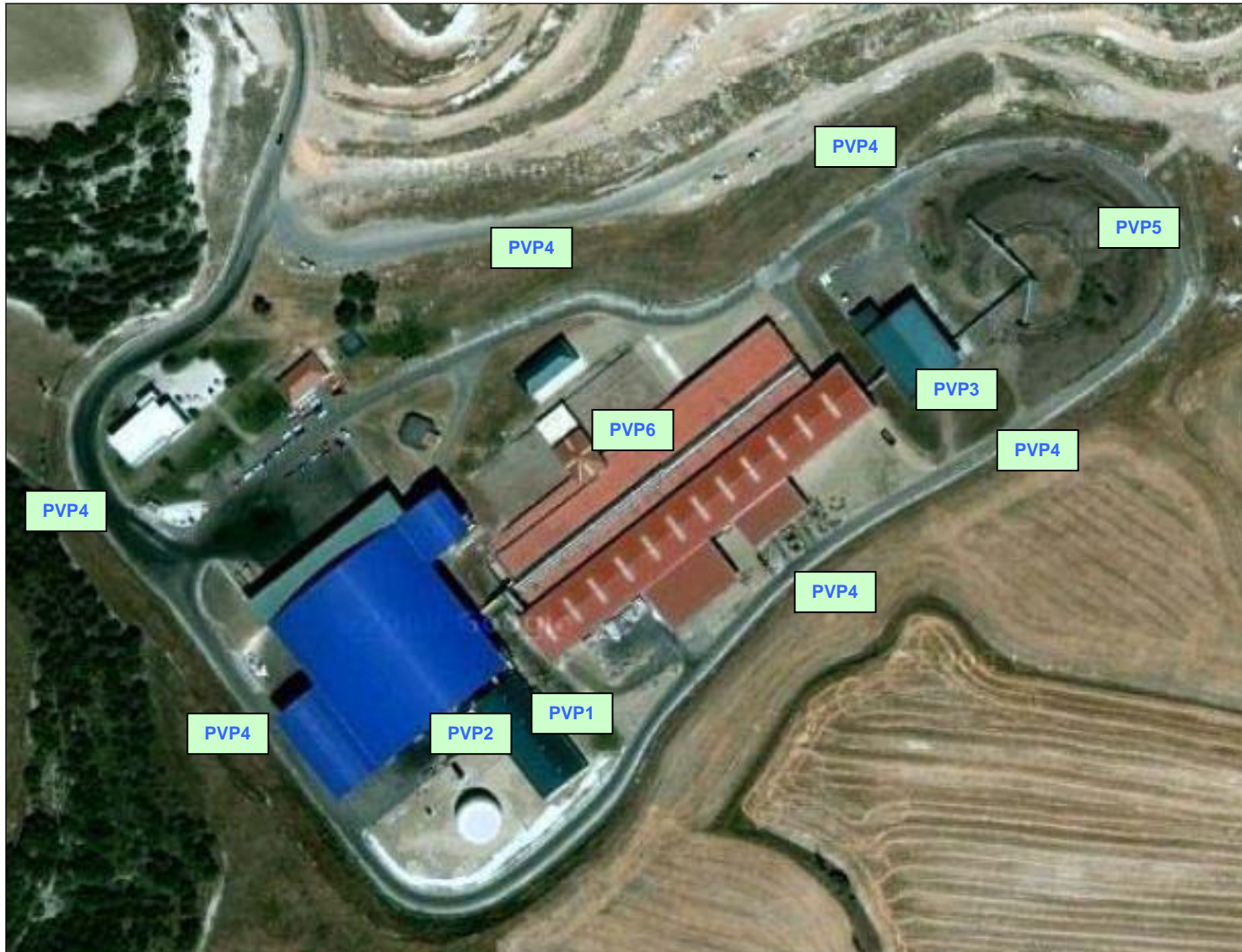
Vista general de la Planta de Tratamiento de RSU de Valladolid.
