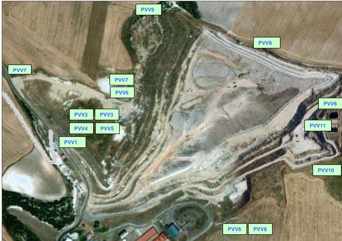
Vista general del Vertedero de Residuos no Peligrosos de Valladolid.
