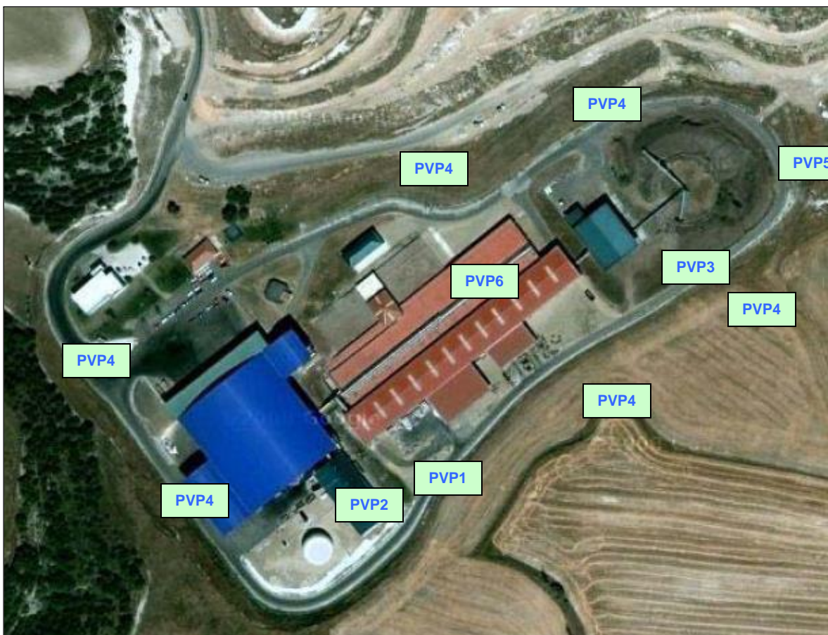
Ilustración 1: Vista general de la planta de tratamiento de Valladolid
